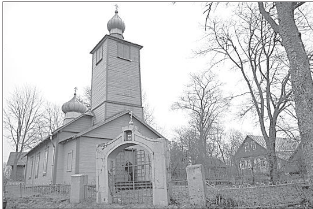
Храму нужны прихожане и ремонт.
