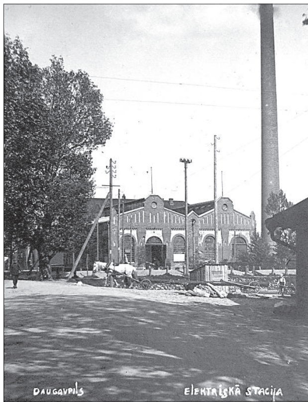
Электростанция в годы Первой республики.
