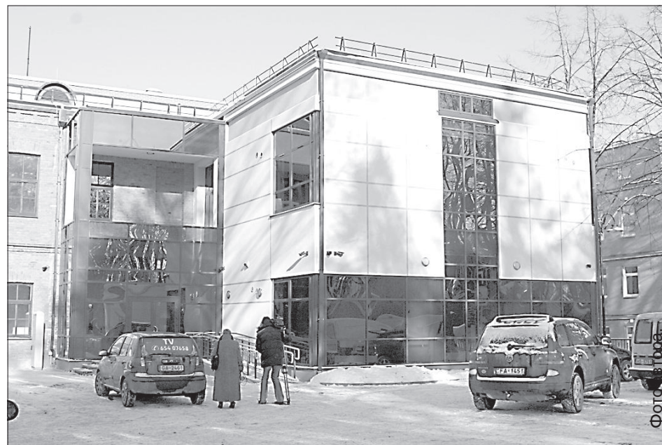
Новая двухэтажная пристройка.
