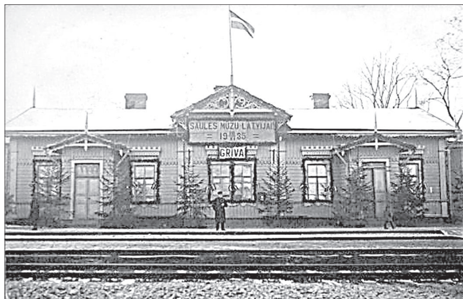
Железнодорожная станция «Грива» в 1930-х годах.
