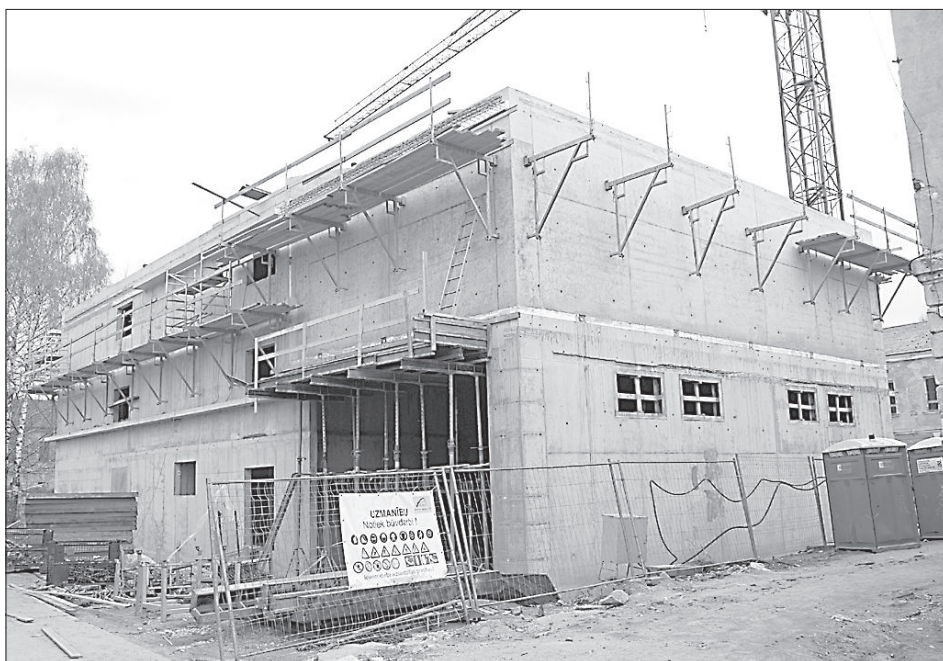
Строющийся изолятор временного содержания.
