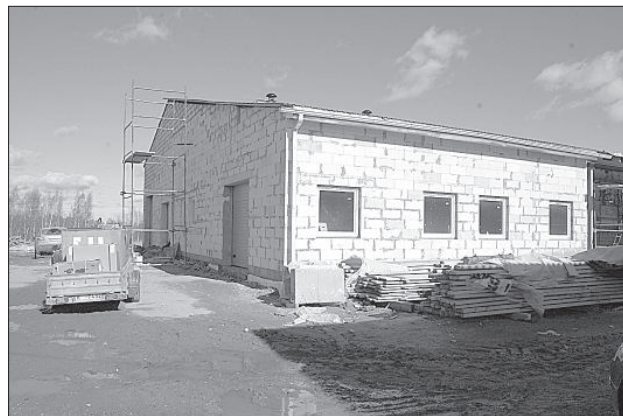
Идет строительство современной фермы.
