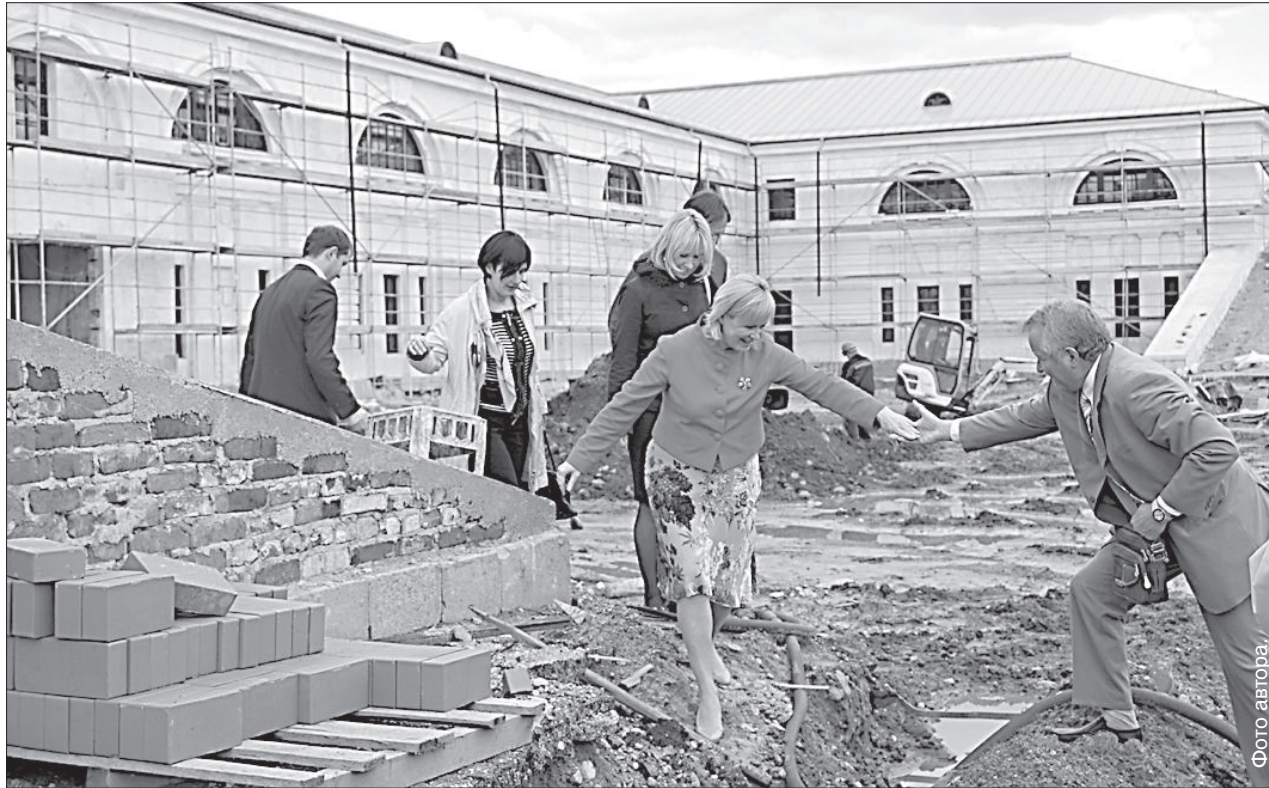
Жанете Яунземе-Гренде осмотрела реставрируемое здание арсенала внутри и снаружи.
