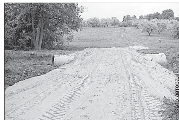
Когда наезженная дорога будет зарегистрирована, ее реконструируют.
