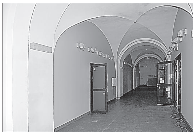
Ремонт старых толстых стен.
