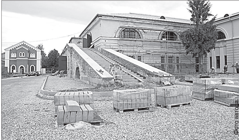
Строительство идет полным ходом.
