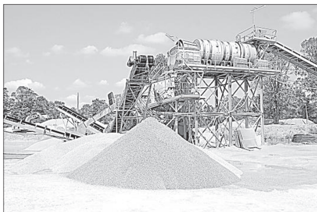
Территория переработки камня и гравия.
