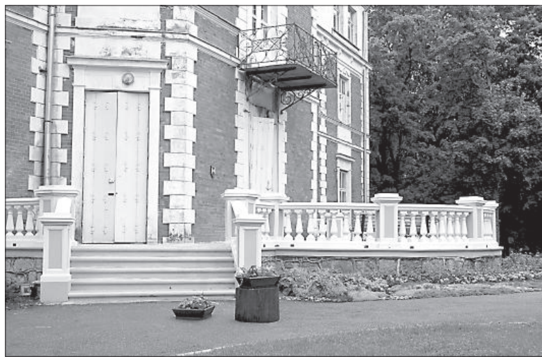
Наружный балкон тоже прошел реставрацию.
