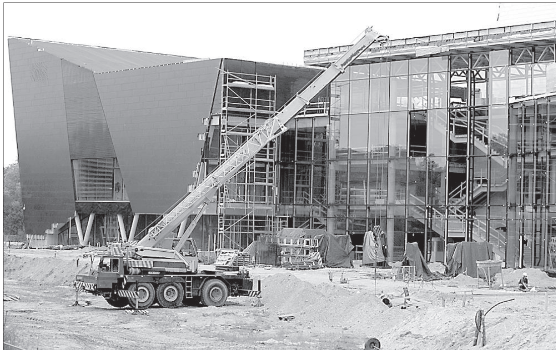
Строительные работы идут полным ходом.
