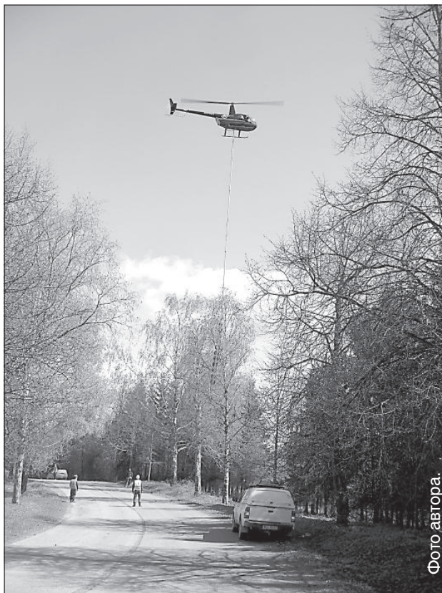
Расчистка воздушных линий при помощи вертолетов.
