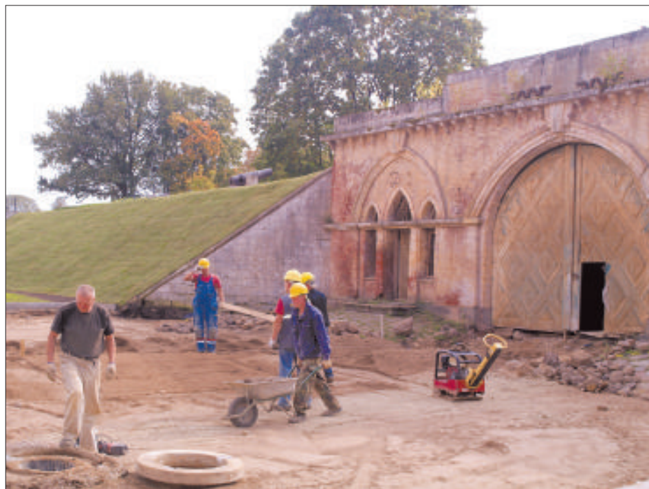
Благоустройство территории идет полным ходом.
