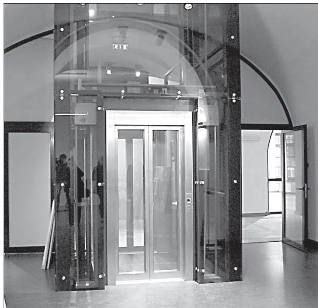
Лифт уже ездит между этажами.
