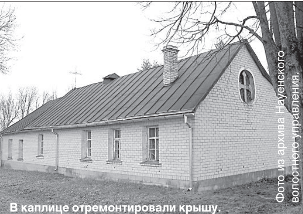
В каплице отремонтировали крышу.
