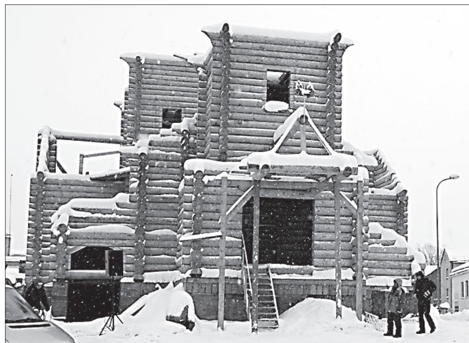
Деревянный сруб будущего храма.
