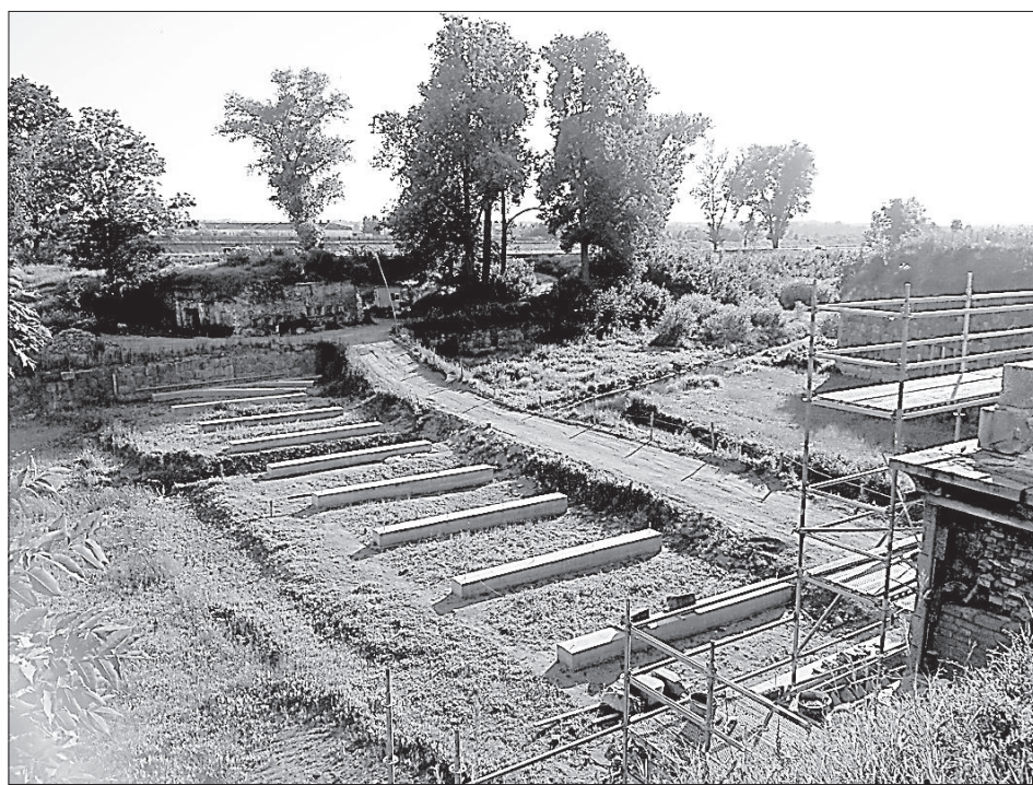
Основы будущего моста для туристов.
