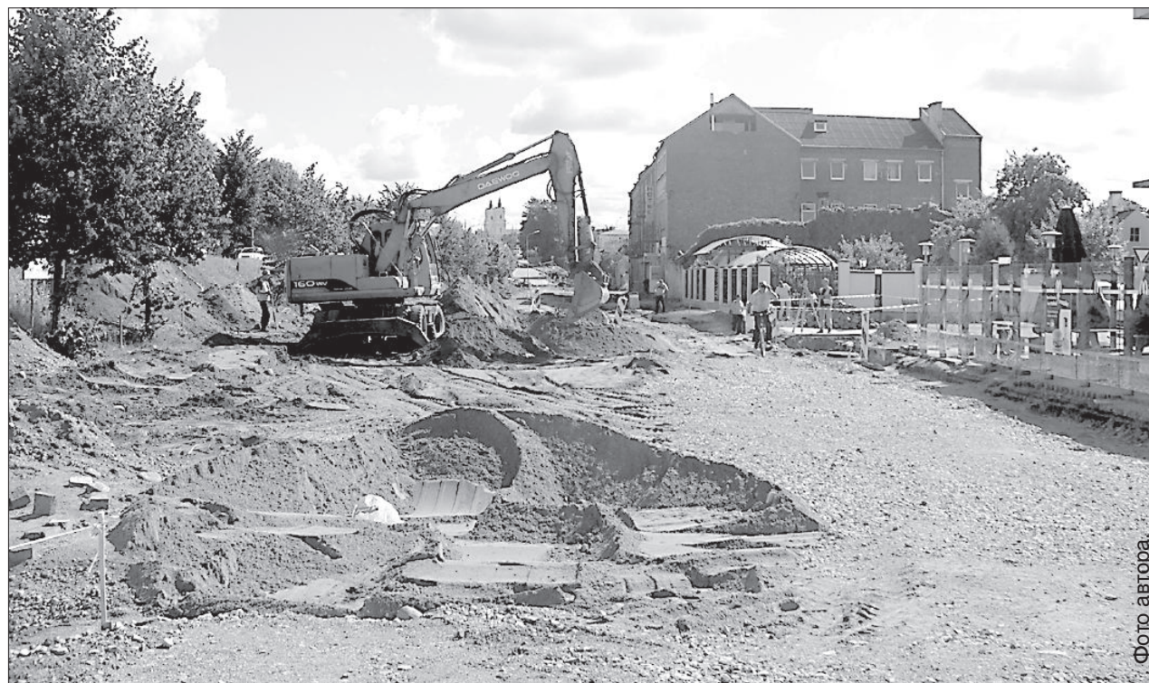
Строительные работы на улице 18 Новембра — один из вопросов, к которому обращено пристальное внимание.
