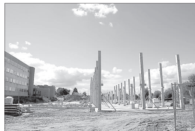
Строительство лаборатории в самом разгаре.
