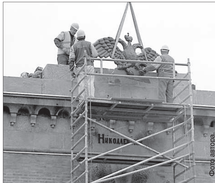
Подъем и установка чугунной птицы.
