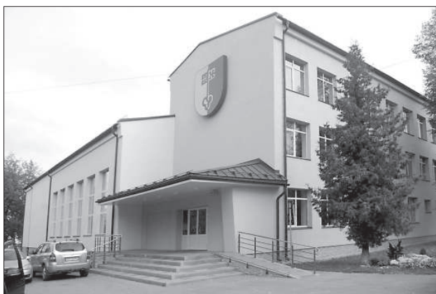
Отремонтированный Дом культуры.
