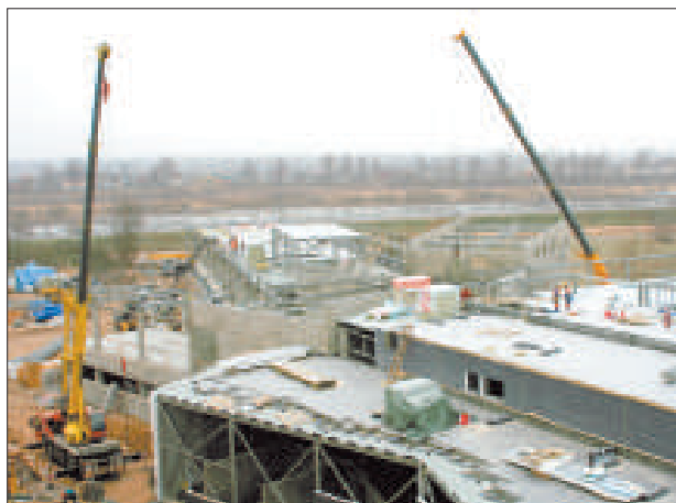
Строящийся лабораторный корпус ДУ.
