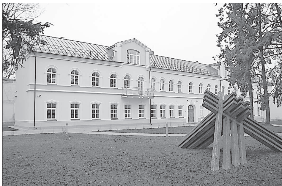
В историческое здание вдохнули вторую жизнь.
