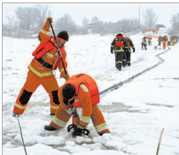
Пробивают во льду канал для бонов.
