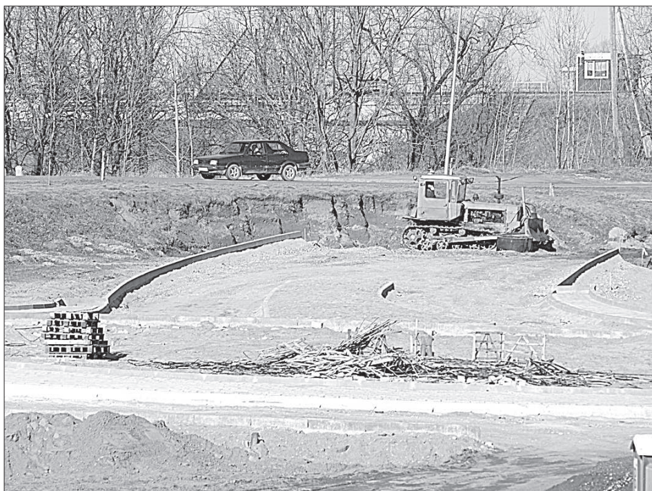
Работы по созданию транспортной развязки на ул. Даугавас.
