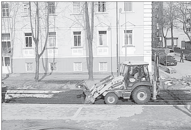
Продолжаются работы по перекладке трамвайных путей.
