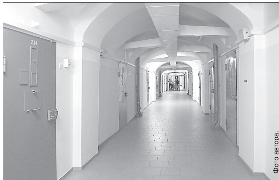
1-й и 2-й этажи отремонтированы.
