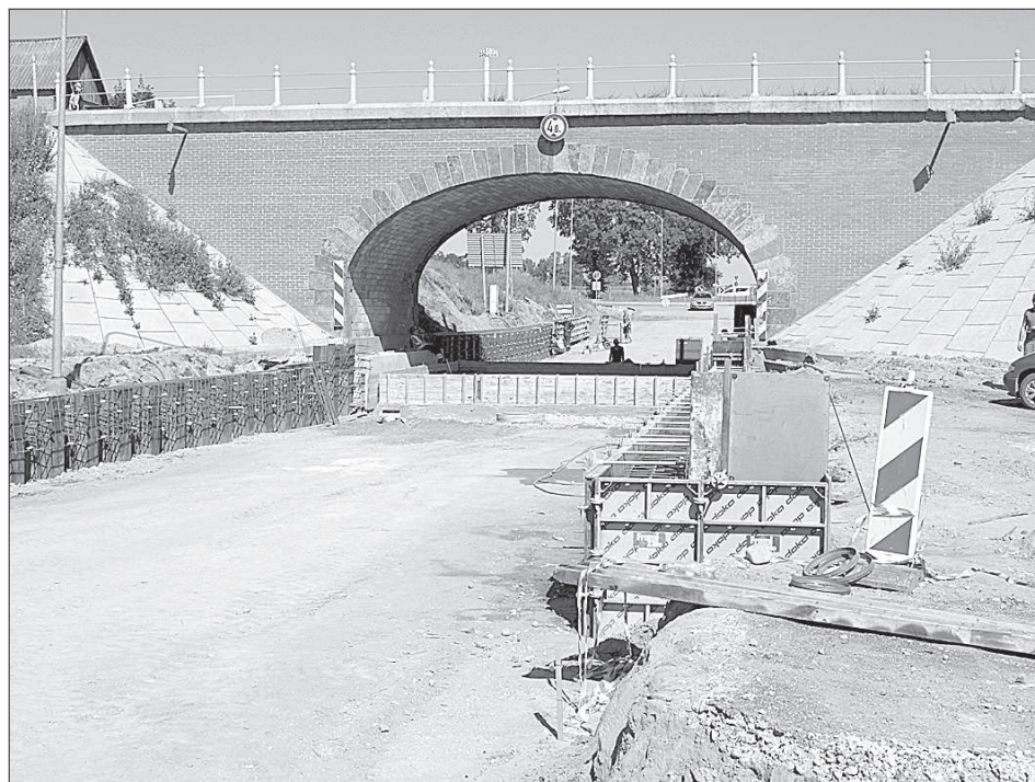
Строители бетонировали дорогу под ж/д аркой на ул. Даугавас.
