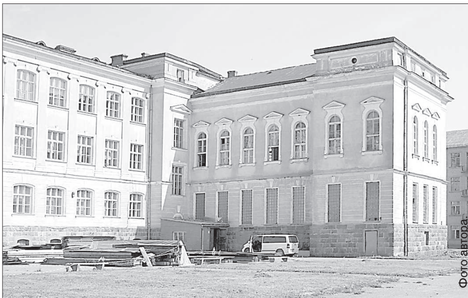
На одном из корпусов школы-интерната начался ремонт крыши.
