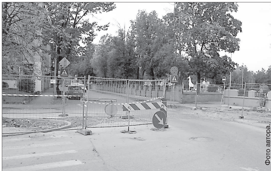
Наибольшие неудобства для передвижения горожан связаны с проектом реконструкции канализационных коллекторов.
