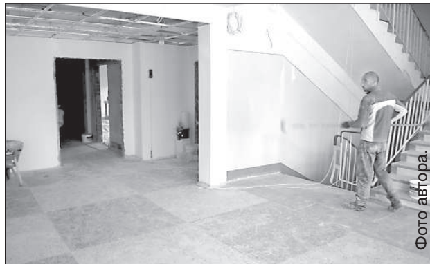
На первом этаже школы ремонт в полном разгаре.
