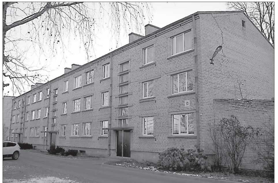
Замена крыши и утепление чердака обойдутся почти в 40 тыс. евро.
