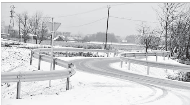
Реконструированная ул. Страдниеку оборудована барьерами безопасности.
