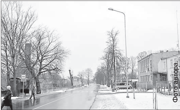
На ул. Киегелю отремонтировано покрытие и оборудовано уличное освещение.
