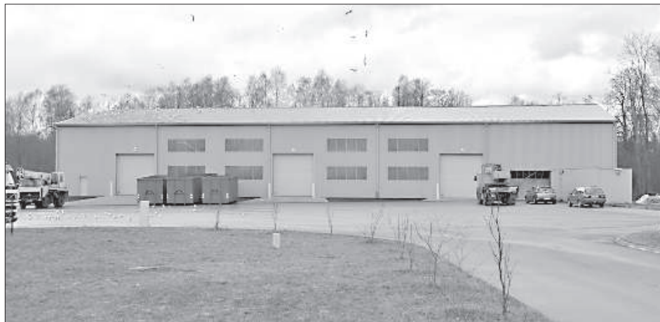
Современное оборудование установлено в ангаре.
