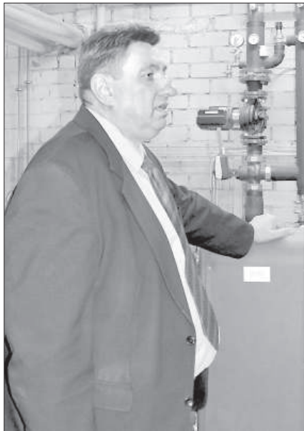
Я. Белковский показывает обновленные теплоузелы.
