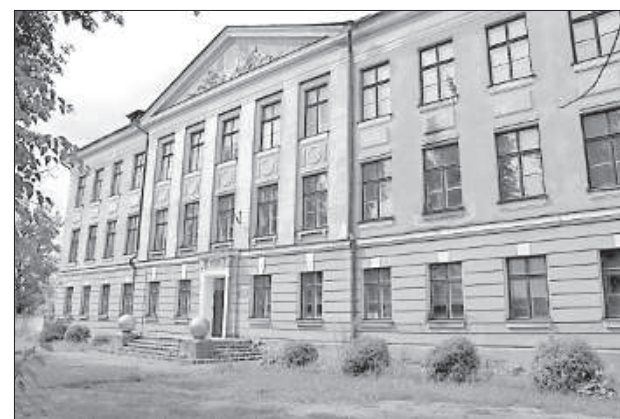
Школа на Юдовке строилась как военный госпиталь.
