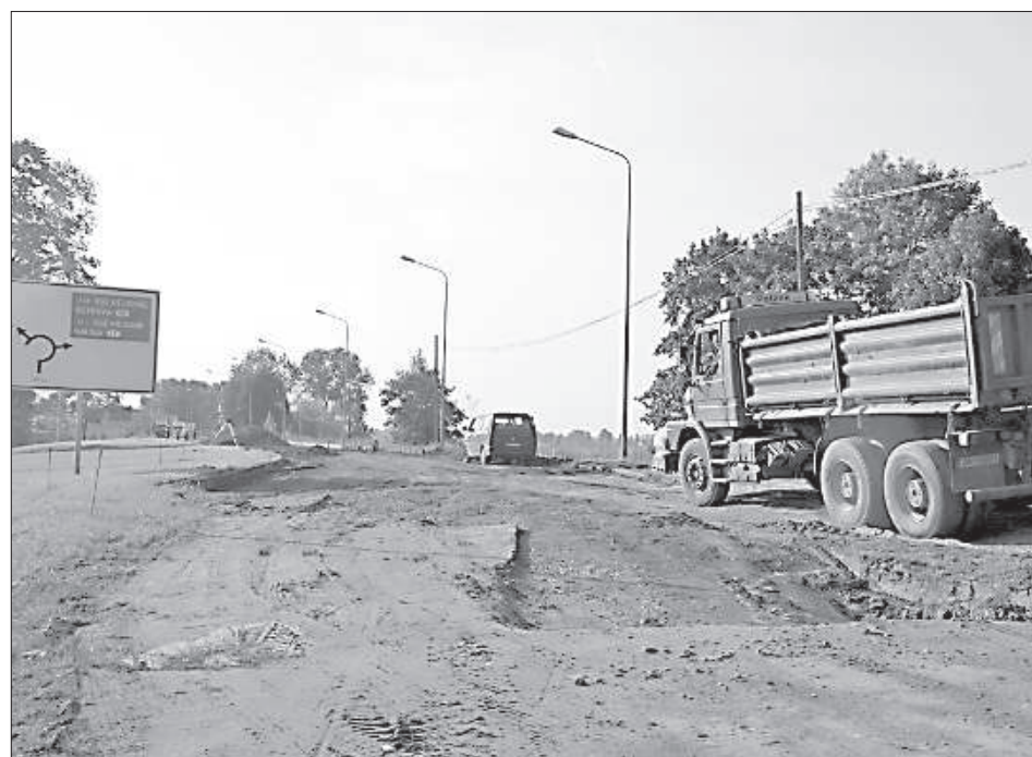
Обустраивается въезд по направлению из Риги на дамбу.
