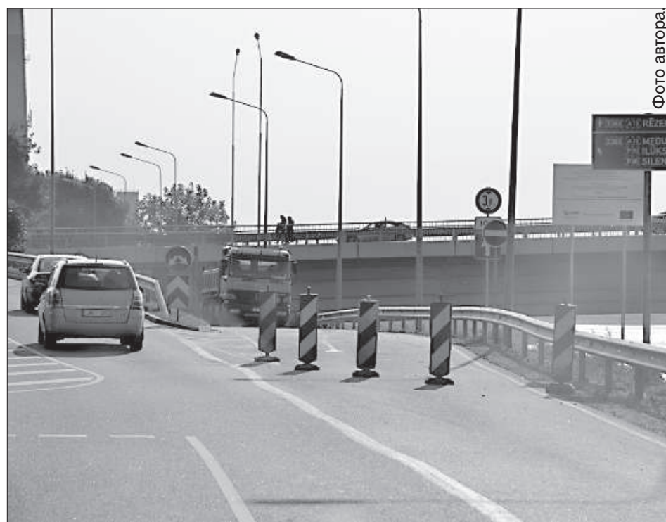
Проезд под мостом закрыт до 3 ноября.
