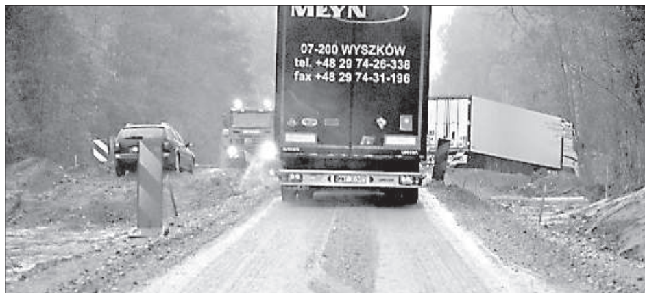
Самые глубокие траншеи водители объезжают по фрезерованному материалу, который во время дождя превращается в грязь.
