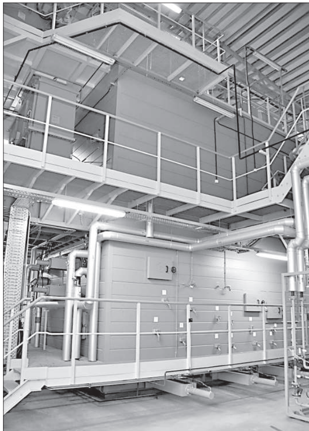
Паровые котлы производят 12,3 т пара в час.
