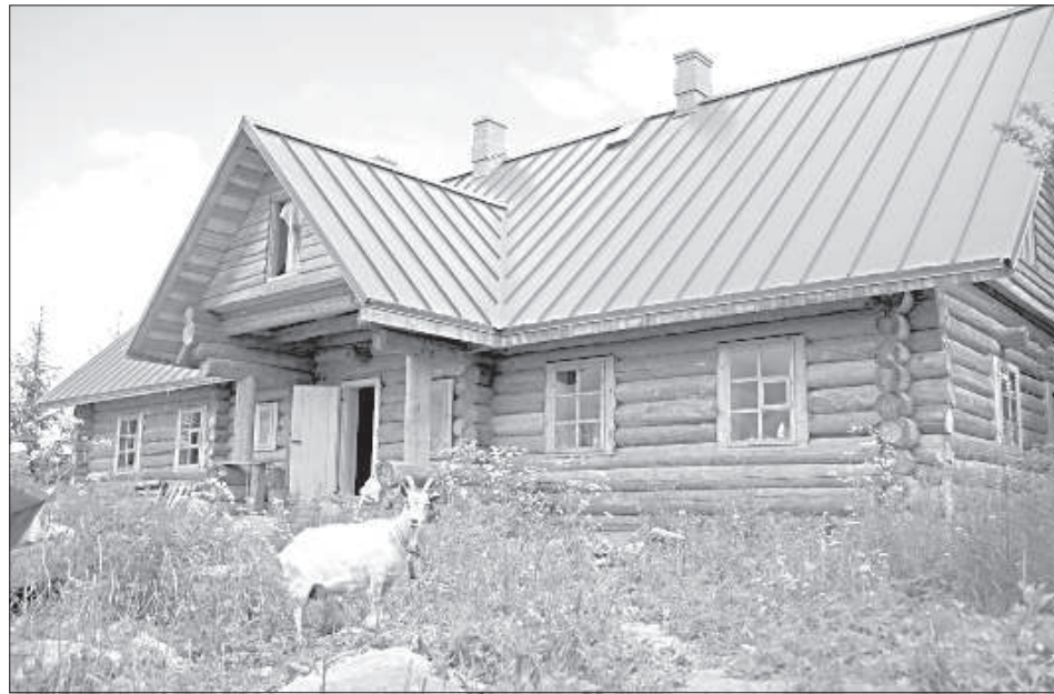
В «Лаукрозес» строится новый дом для большой семьи.
