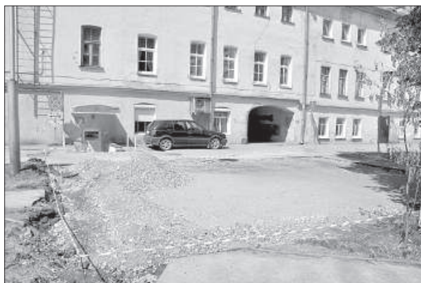
Стоянка машин перед строительными работами.
