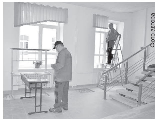
Строители завершают последние работы.
