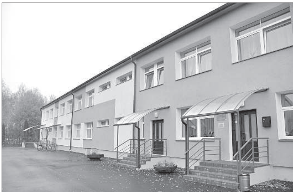
Утеплен и покрашен фасад центра.
