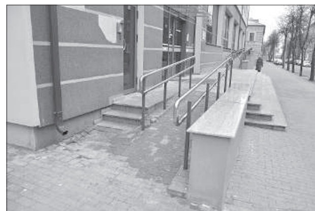
Пандус обеспечивает клиентам доступ в здание ГАСС.
