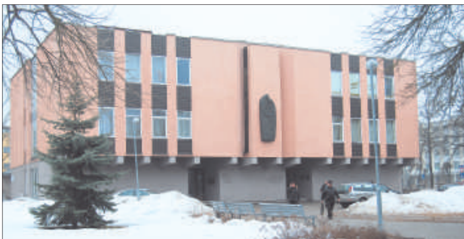
В следующем году запланировано утепление и ремонт здания Даугавпилсского загса. Оно будет приспособлено для людей с нарушениями опорно-двигательной системы.
