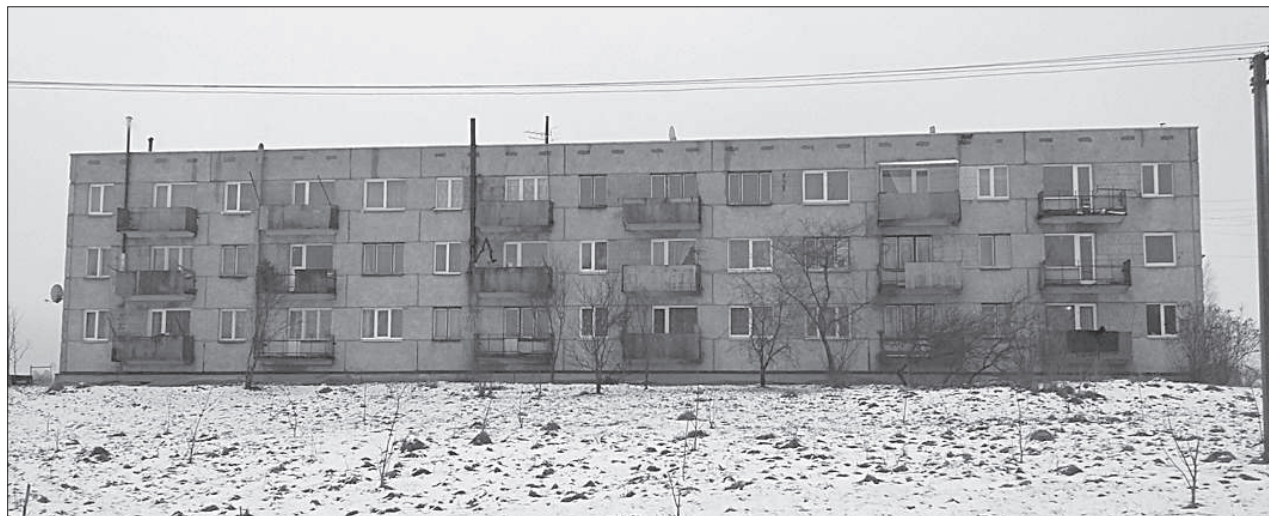
У дома по ул. Лидумниеку, 15 отремонтирована крыша, заменены водопроводные трубы и утеплен 1 — й этаж.
