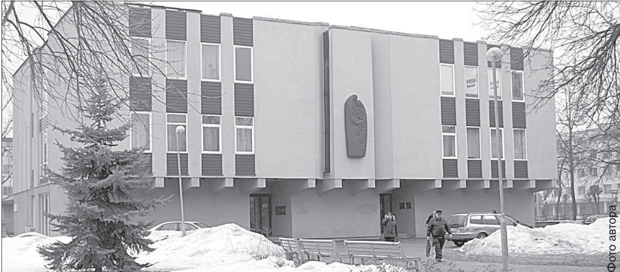
Здание загса будут утеплять.
