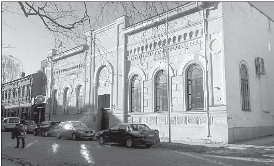
Центр обслуживания разместился в здании на ул. Лачплеша, 39
