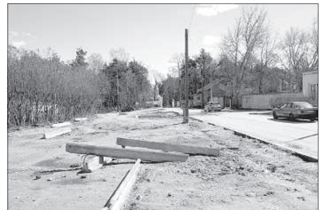
Оборудование стоянки на ул. Клуса.
