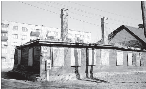
Сгоревший дом на ул. Миера, 129
