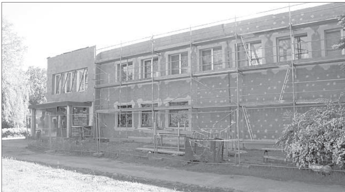
В скором времени работы по утеплению здания будут закончены.
