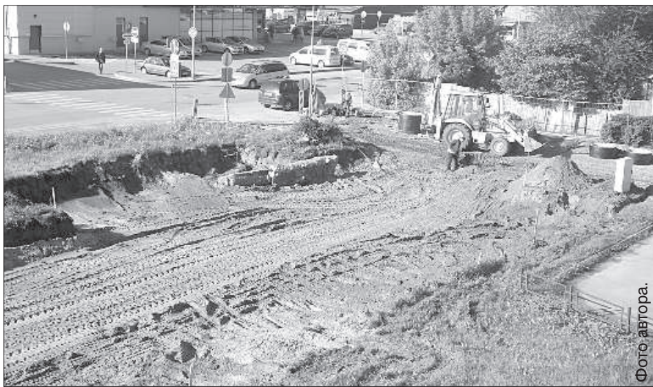
Строительство новой парковки на ул. Кандавас.
