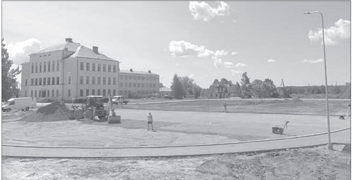
Строительство нового стадиона.
