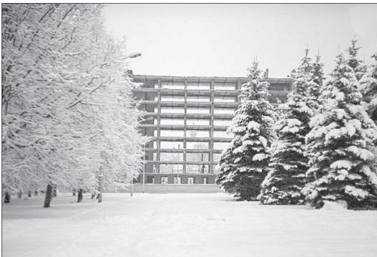
Здание гостиницы во время реконструкции в 2004 году.
