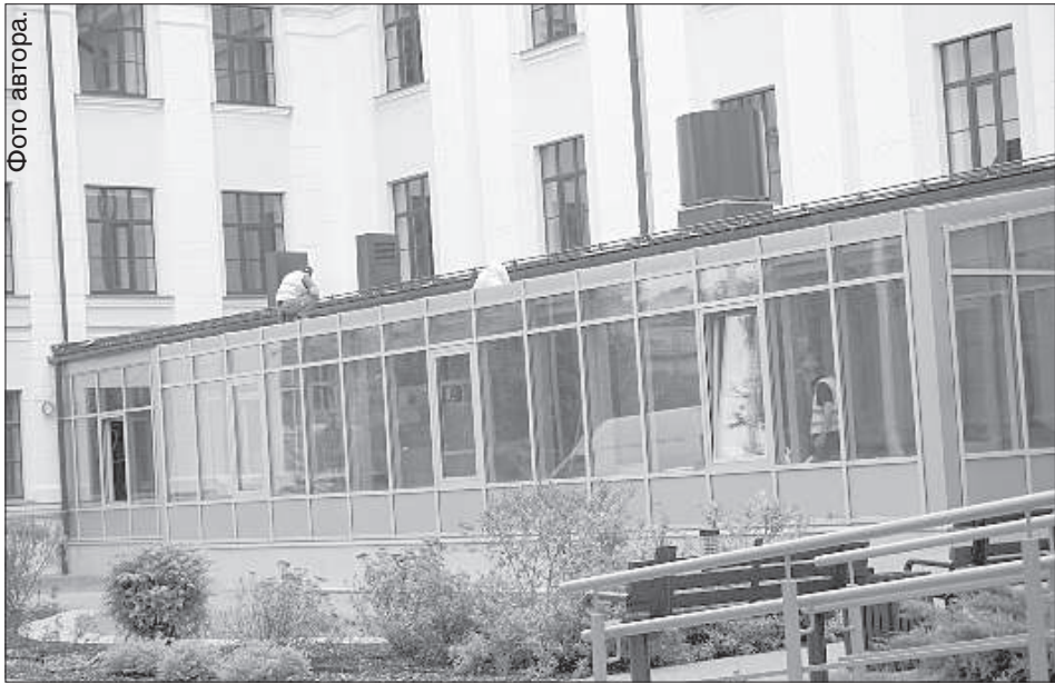
Темпы ремонта и строительства в 3-й средней школе не вызывают опасений.
