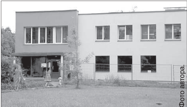
Латгальский зоосад уже обновил свой фасад.
