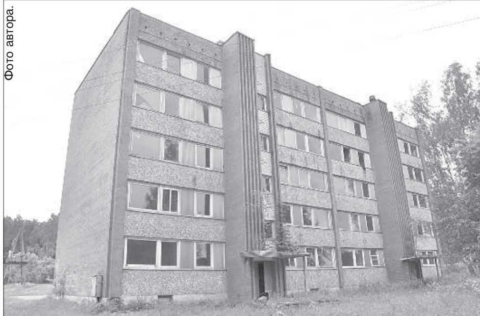
Пятиэтажный дом ждет возрождения.
